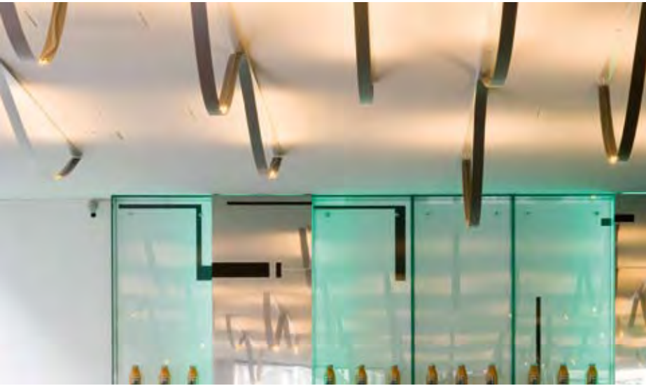
LED-lyskilderne er fæstnet langs smalle stålskinner og udgør lampekonstruktioner, som rummets generelle belysning. Foto: Jens Markus Lindhe.
