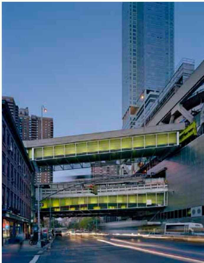
Triple Bridge Gateway, New York. Farverne er malet på betonkonstruktionen. Selve lyset er hvidt. Foto: Archphoto.
