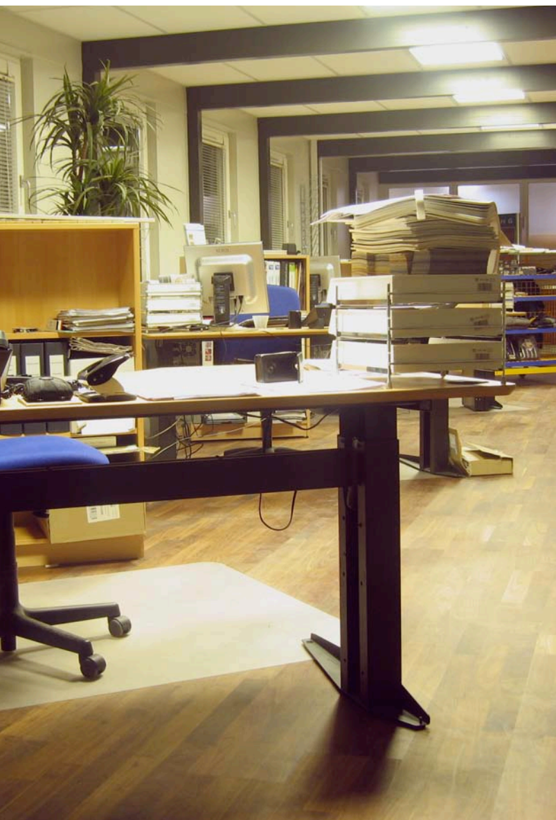
Armaturerne på dette kontor i Aalborg er udstyret med nye danskudviklede LED-armaturer fra Ledtech A/S med kun 3,9 W/m 2 . Hvert armatur har 882 hvide dioder og bruger 42 W.
