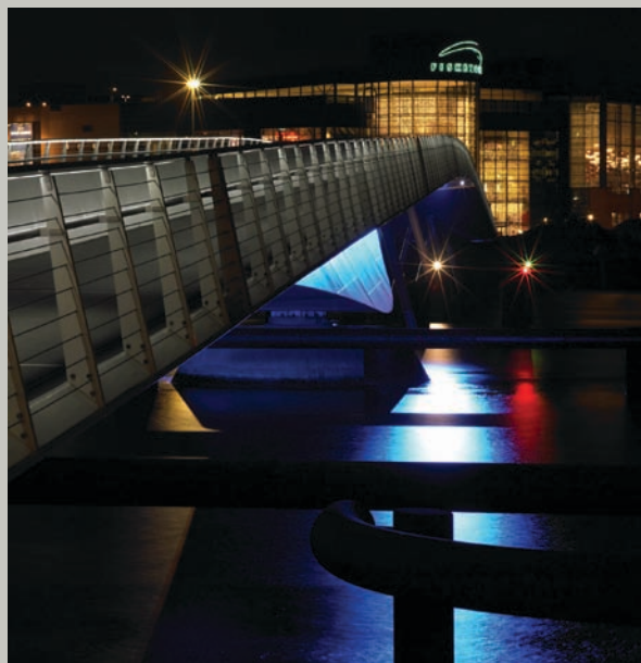
Lyset er indbygget i håndlisterne. Brofagernes underside er belyst med projektører, som giver mulighed for farveskift.
