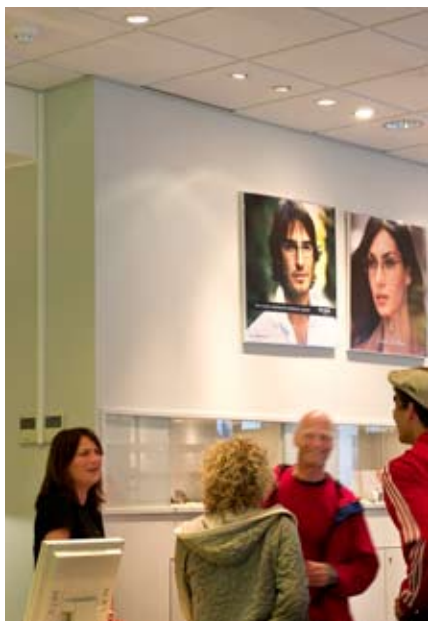
Væggene belyses med Pixel Plus indbygningsarmaturer på 70W (3000° K) metalhalogenlamper kombineret med Pixel Plus 35 W ES halogenlamper. Foto: Ole Ziegler.
