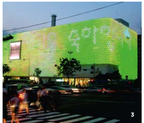
Billede 1-3: Mediafacaden på Galleria Fashion Mall i Seoul er et vendepunkt inden for mediafacader, fordi det ikke er lys, der er tilføjet til en facade, men det er facaden i sig selv der skaber farven og lyset. Foto: Arup Lighting.
